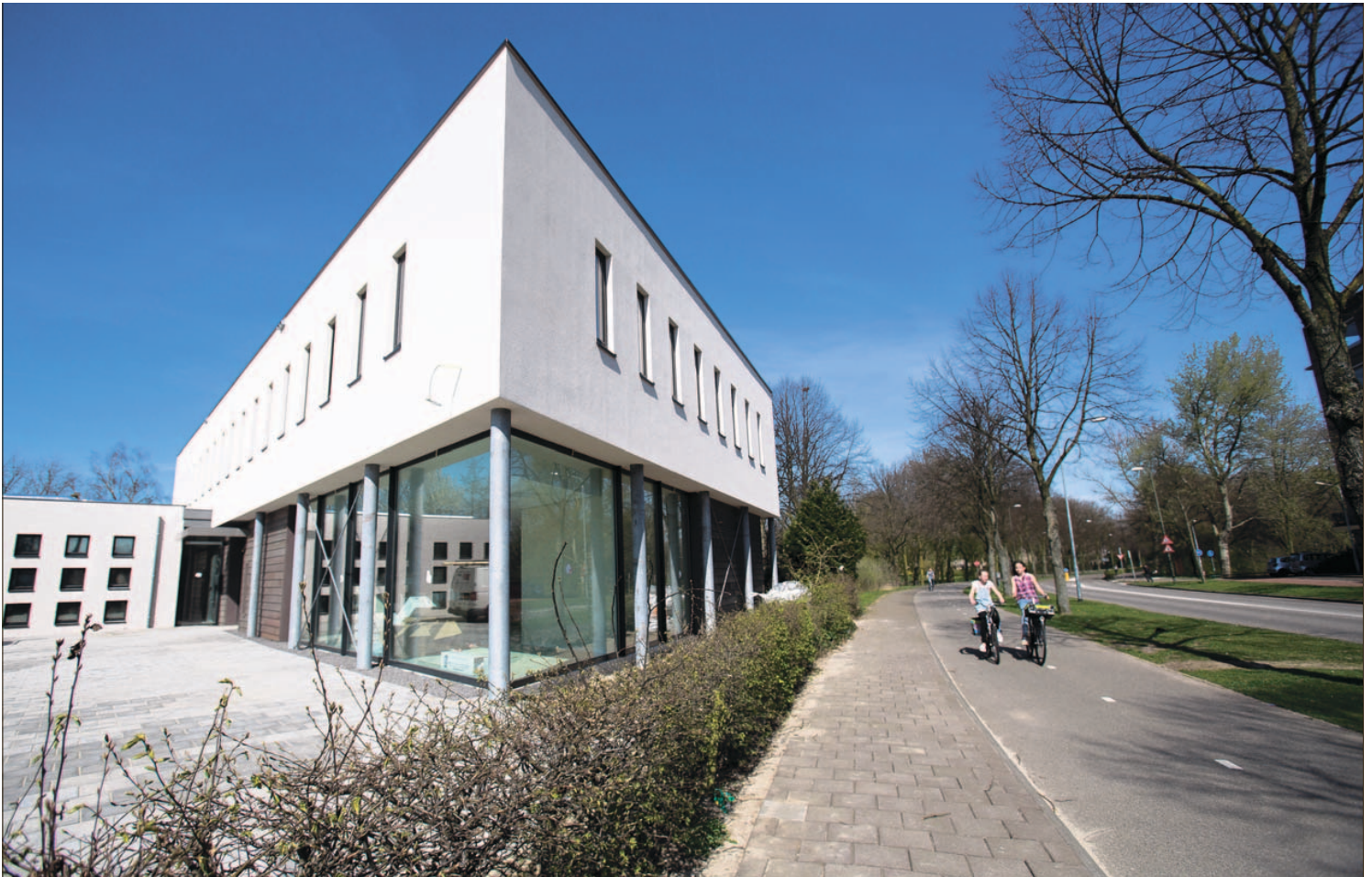
■ Het nieuwe gezondheidscentrum aan de Van Broeckhovenlaan. Vanaf 4 mei zitten de huisartsen er, samen met andere gezondheidsdiensten. foto Sandra Peerenboom
